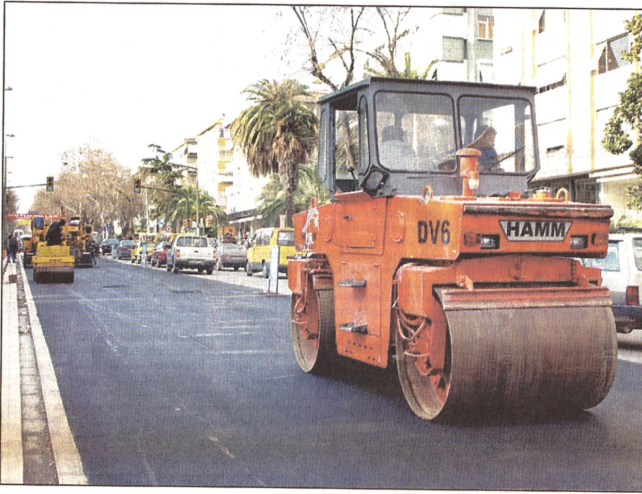
Kadıköy Belediyesi, başta Bağdat Caddesi olmak üzere Büyükşehir Belediyesi'nin yarım bıraktığı altyapı çalışmalarını tamamlıyor...
